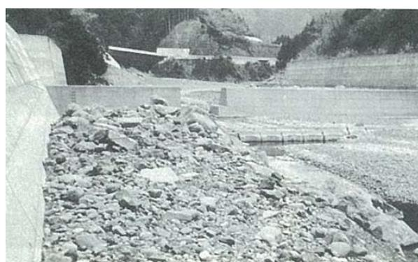
図5-4 永瀬ダム上流端に設置されている貯砂ダム
