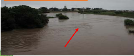
常呂左岸の出水状況 (KP1.5付近)
