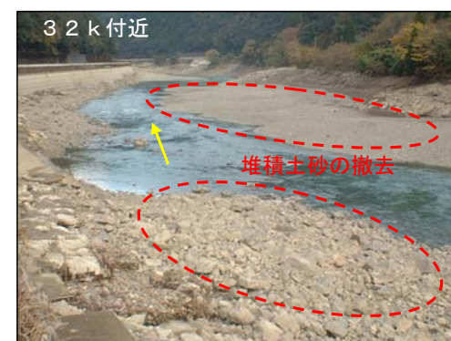
部分的な堆積土砂の除去
