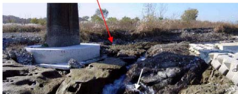
橋脚基礎部が洗掘された多摩川水系浅川の事例
