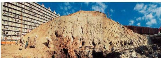
計画高水位までの洪水流量による浸透や洗掘作用に対して、より高い安全性を持たせ、破堤による壊滅的な被害の発生リスクを軽減する。
