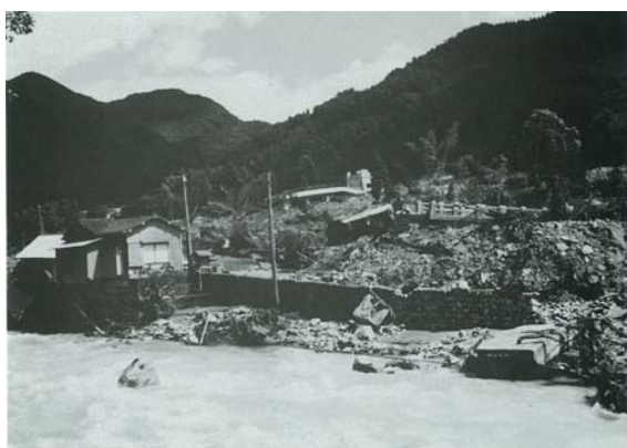
揖保川が土砂で埋没し流路が変わった状況 （ にしごか 宍粟市一宮町西深）
