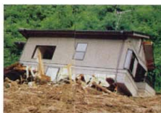
土石流による被害状況 (民家流出)
