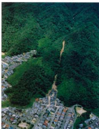
安川左支川の土石流氾濫状況
