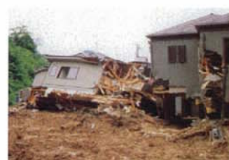
土石流による被害状況
