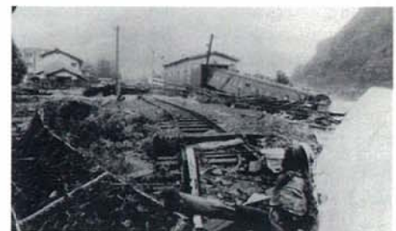
昭和 47 年 7 月豪雨 加計駅付近の被害状況
