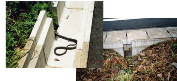
道路脇に設置する側溝に切り欠きを設けることにより、側溝内に小動物が落下しても自力で脱出することが可能。
