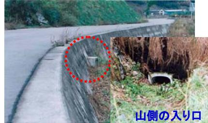
道路下に横断管（小規模なトンネル）を設置することにより、道路の反対側へ移動することが可能。
