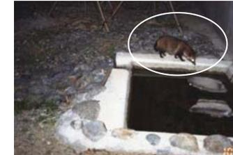
道路下に誘導するよう、橋梁の下などに水飲み場を設置。（写真の動物はタヌキ）
