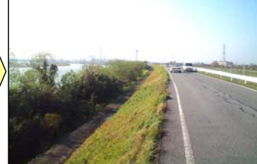
現在の萩原堤防
