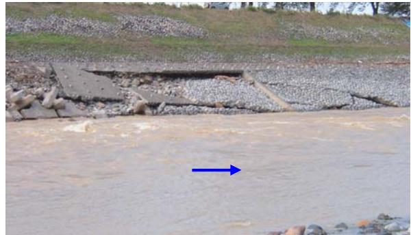
堤防護岸欠壊及び根固流出
