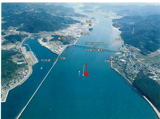
【川内川河口部(川内河口大橋付近)】
