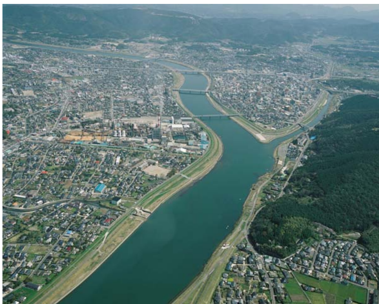
写真 8-5 川内川下流部（薩摩川内市街部付近：11km）
