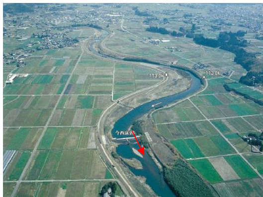
【川内川上流域(113k000付近)】
