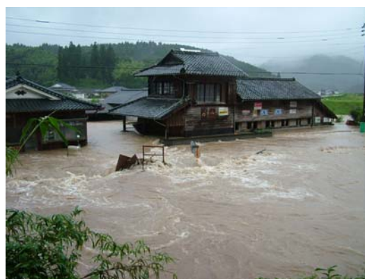
写真 4-8(2) 湧水町浸水状況
