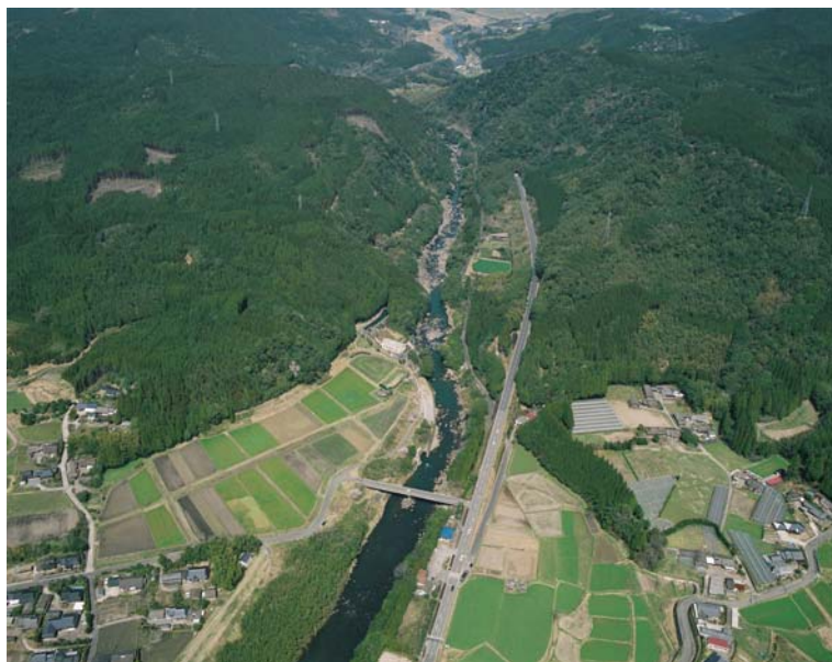
写真 8-1 川内川上流部（永山狭窄部付近：90km）
