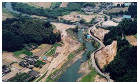
轟狭窄部の開削工事(旧栗野町)
