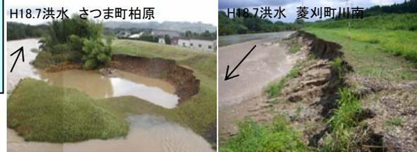
細粒分が多く、密度が小さいため堤防が侵食されやすい。また、透水性が大きいため、吸い出しによる堤体の空洞化等による堤防決壊が懸念される
