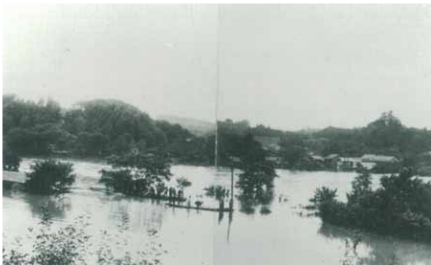
【昭和 15 年 9 月洪水 橋付近】
