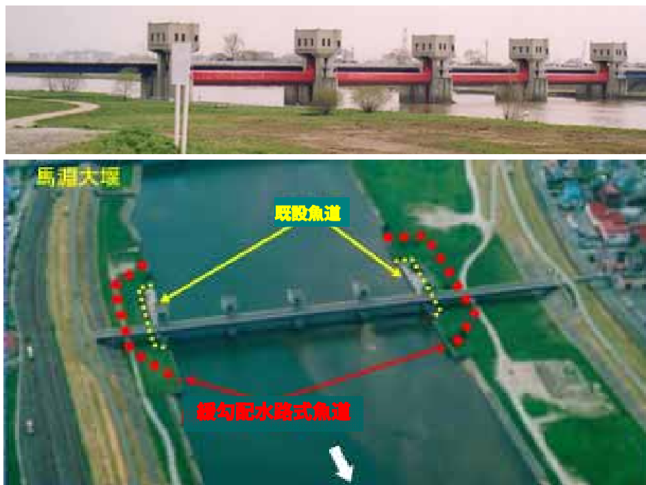
馬淵川大堰全景
