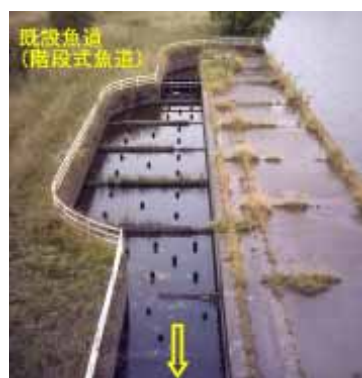
【既設魚道：階段式魚道】
