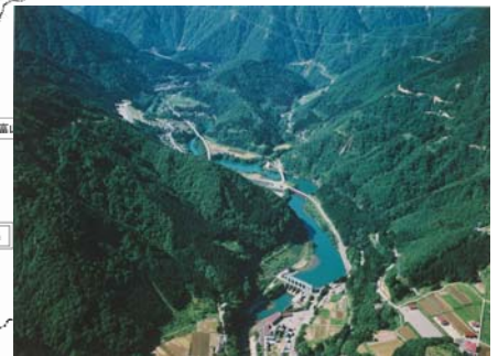
④赤尾ダムより上流を望む
