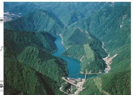
⑥椿原ダムより上流を望む
