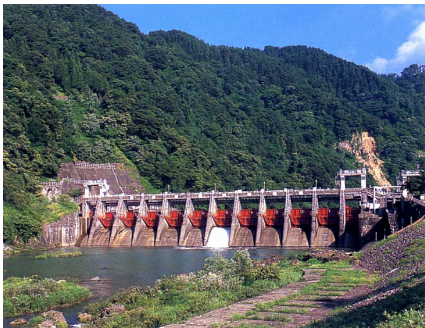
庄川用水合口ダム
