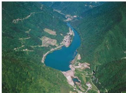
③小原ダムより上流を望む
