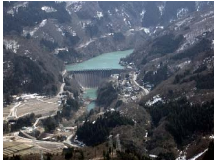
①小牧ダム付近より上流を望む
