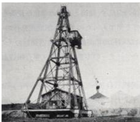
タワーエクスカーベーター新潟機稼働状況
