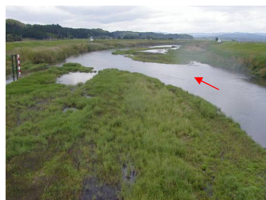
【荒田天神橋(71k000付近)から下流方向】
