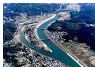
湯之尾捷水路
