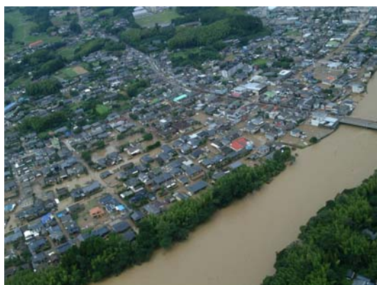
写真 4-8(3) さつま町虎居地区浸水状況
