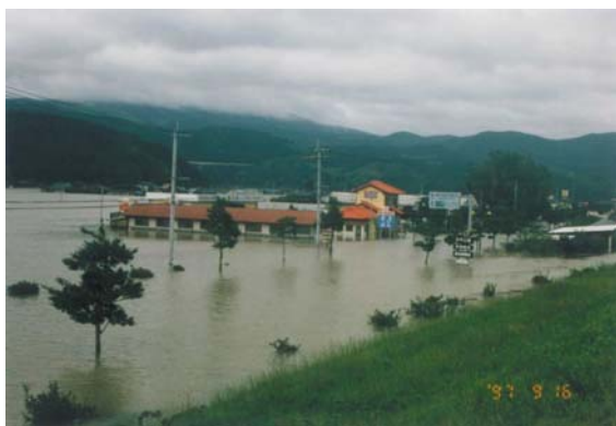
写真 4-7(2) 湧水町浸水状況 （旧栗野町中津川地区）
