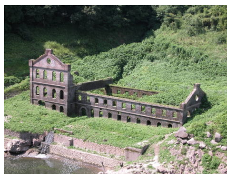
写真 5-3 鶴田ダム湖に姿を表す旧曾木発電所
