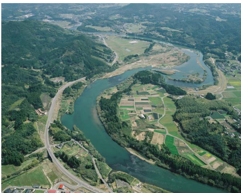
写真 8-4 川内川中流部（倉野地区付近：27km）
