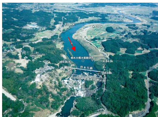
【川内川上流域(64k000付近)】
