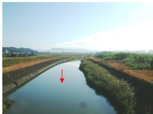
【池島大橋(110k300)から上流方向】
