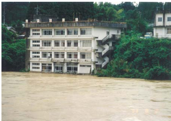
写真 4-6(1) さつま町浸水状況 (旧鶴田町川口地区)
