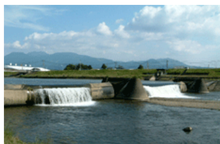
写真 5-1 現在の堂本井堰
