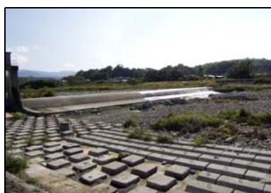
←大川頭首工（右岸から撮影） ・最大 2.8\text{m}^3/\text{s} 、年間 1,440\text{万m}^3 取水（届出書） ・河川水2/3取水、1/3を下流へ分水 2/3取水の内1/4は左岸へ分水（覚書） ・取水した水は右岸の溜池群(仁池、打越池、大窪池、小津森池)に貯留し、かんがい補給を行っている
