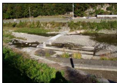
▲天川頭首工（左岸から撮影） 河川水の 2.5\text{m}^3/\text{s} 超過分の最大 8\text{m}^3/\text{s} 取水 取水した水は満濃池に導水
