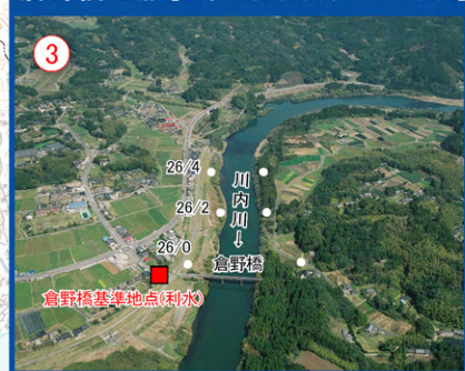
倉野橋地点 [基準地点(利水)、KP26.0 付近]
