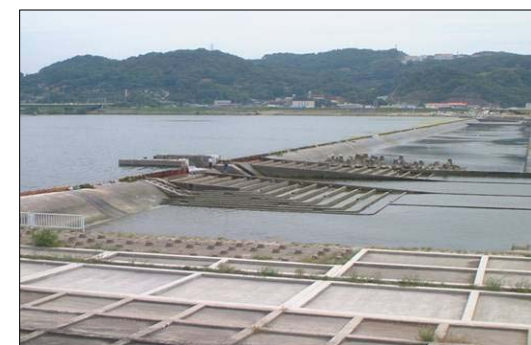
潮止堰の魚道設置状況
