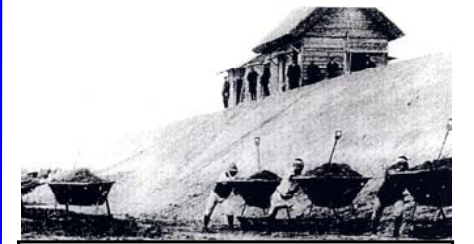
さかつ酒津付近の築堤工事(明治44年)
