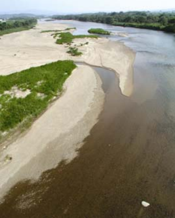
木津川20k付近
