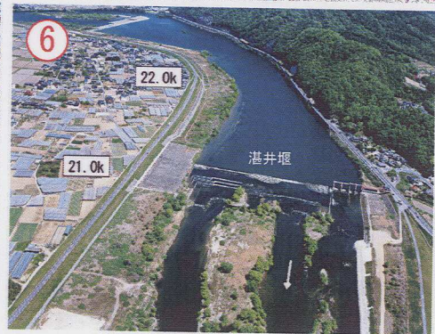
直轄上流端付近
