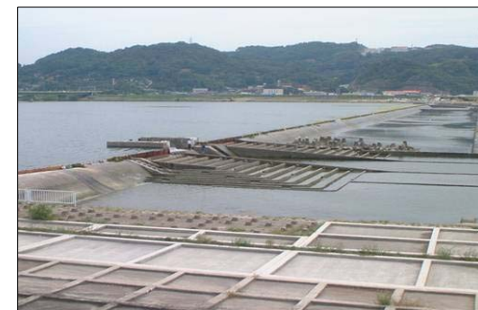
潮止堰の魚道設置状況
