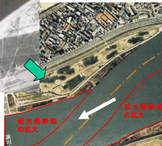
改修後 平成9年
