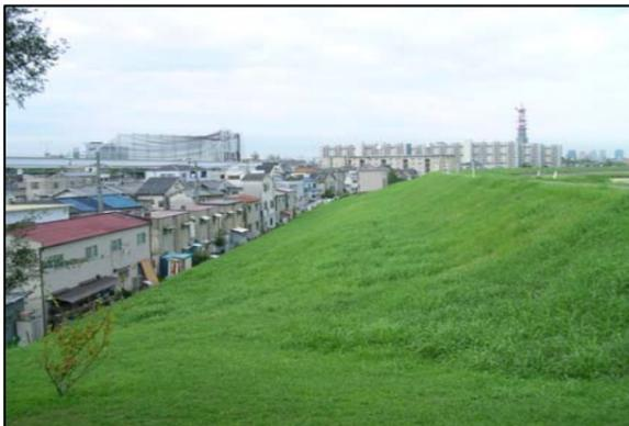
淀川下流部では、人工構造物である高い堤防により洪水から守られた低平地に人口・資産が著しく集積しているため、破堤による被害は甚大なものとなり、都市機能が長期間にわたり停止するなど、社会・経済に大きな影響が発生する。
