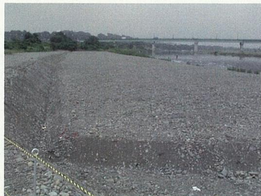
写真 8-3 H18 年度置き砂試験施工状況
