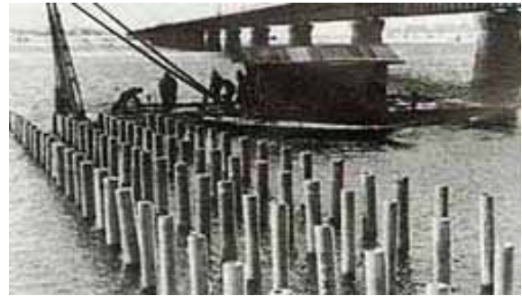
第 2 期改修工事の様子
