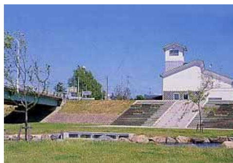
身神川排水機場
