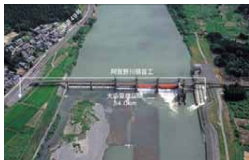
阿賀野川頭首工
