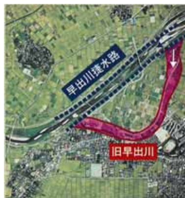
早出川捷水路
