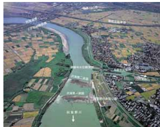
沢海床固工と小阿賀野川
