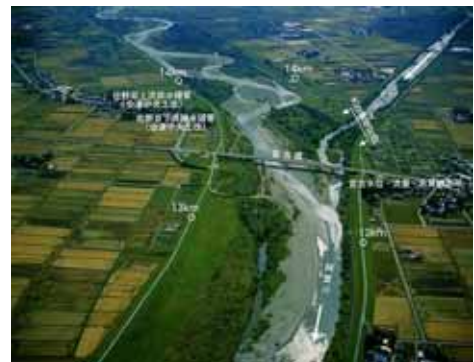
宮川放水路合流点付近
