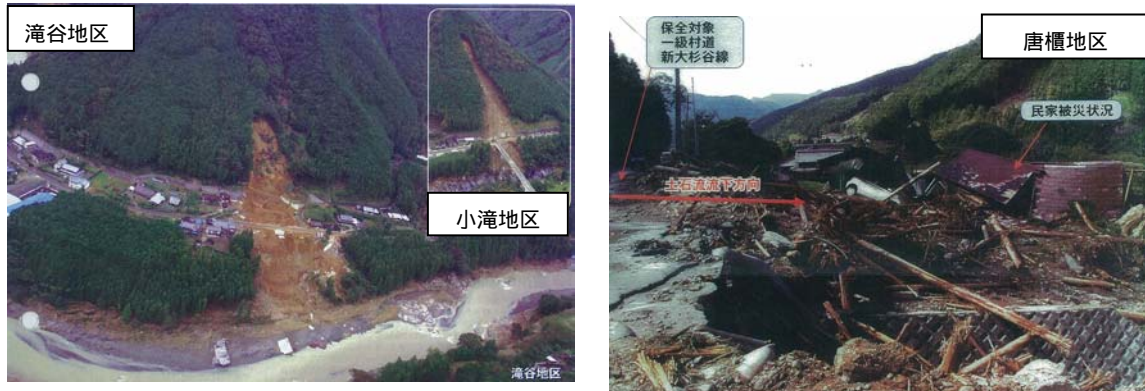
図 5 - 1 土砂災害状況
