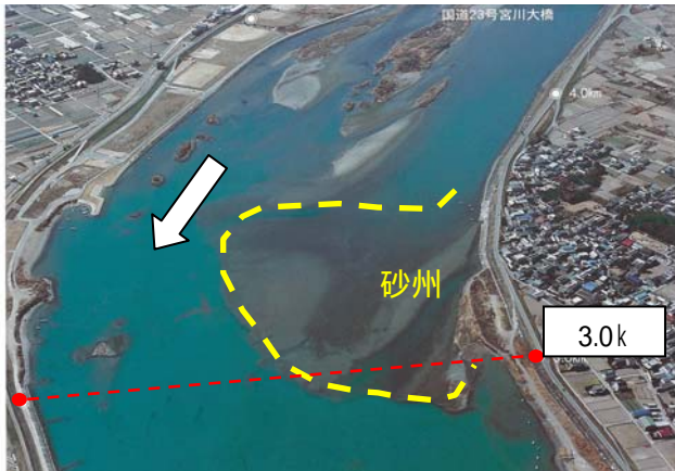
宮川航空写真（H7年撮影 3k付近）
