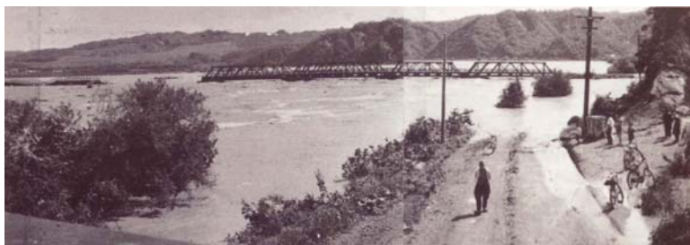
生鼈橋(現旭生橋)
