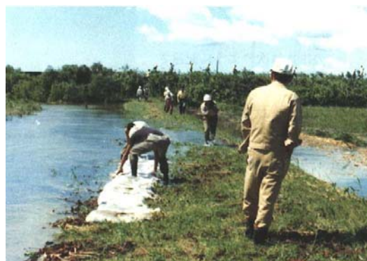
鵡川左支川珍川堤防の応急水防作業
