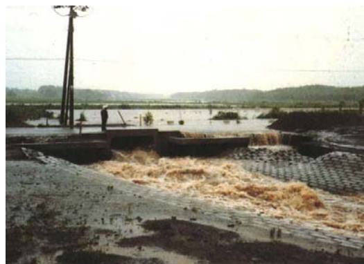
珍川内水氾濫・汐見地区
