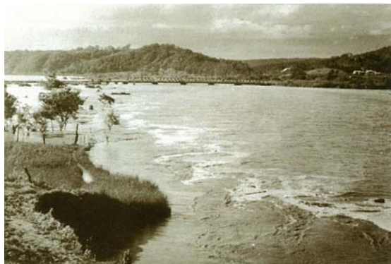
米原地区春日橋取付道路冠水状況
