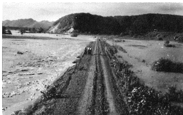
有明地区の冠水状況
