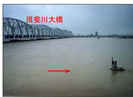
桁下高不足の橋梁の洪水時の状況
