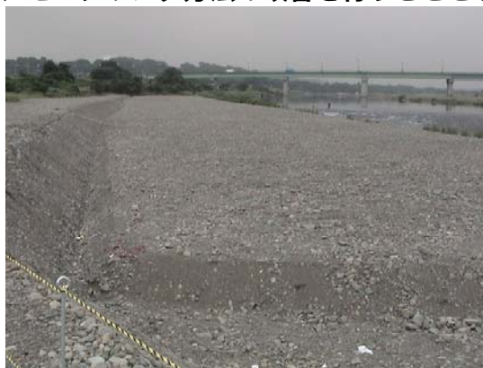
写真 7 H18 年度置き砂試験施工状況
