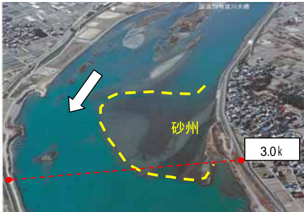
宮川航空写真（H7年撮影 3k付近）
