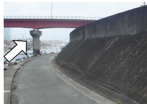
勢田川右岸0.5k付近 高潮堤
