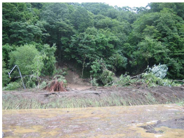
有明築堤道道合流部
