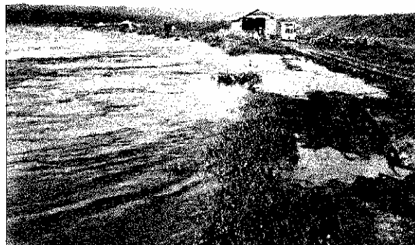
鵠川左岸宮戸築堤工事に使用している土運車流失する
