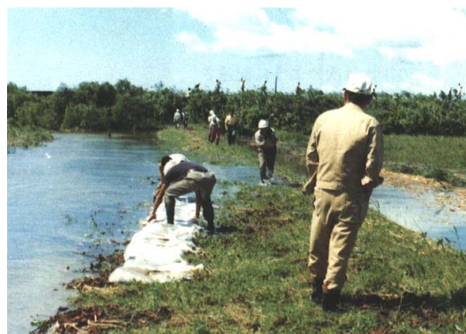
鵒川左支川珍川堤防の応急水防作業
