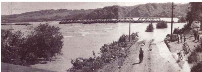
生鼈橋(現旭生橋)
