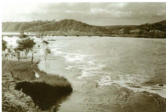
米原地区春日橋取付道路冠水状況
