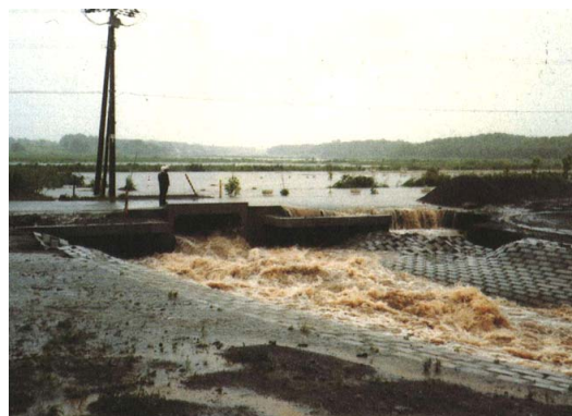
珍川内水氾濫・汐見地区
