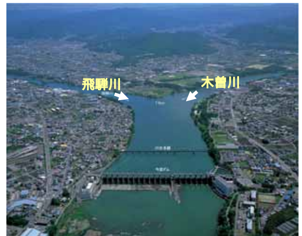
今渡ダム付近の状況
