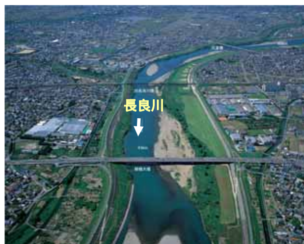
JR 長良川橋付近
