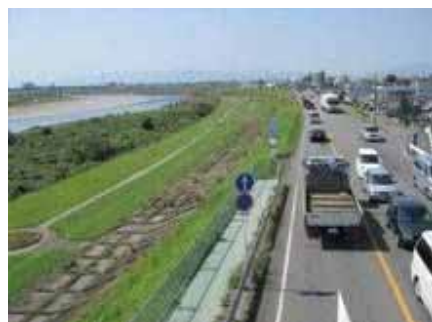
兼用道路の状況 (長良川右岸 50k 付近)
