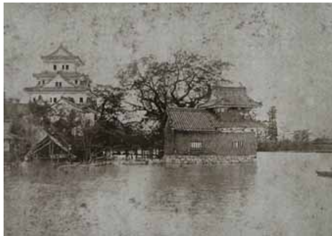
豪雨被害（大垣城周辺の浸水状況）
