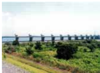
木曽川大堰 木曽川 26k 付近
