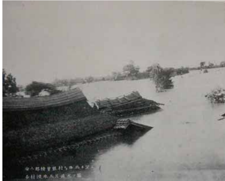
明治 29 年 7 月 豪雨被害（安八郡横曽根付近の浸水）
