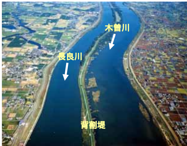
背割堤の状況
