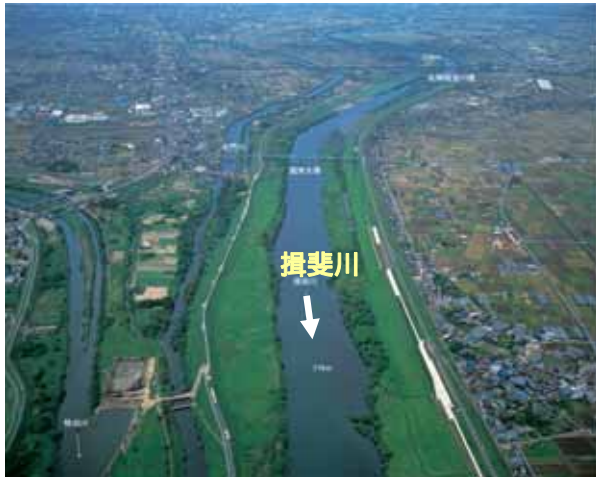
名神揖斐川橋付近
