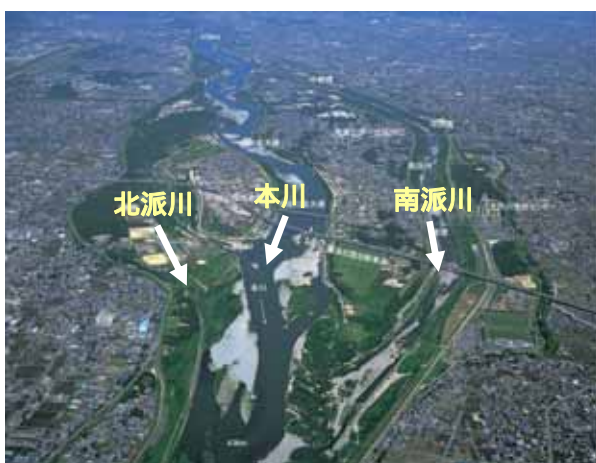
三派川地区の状況
