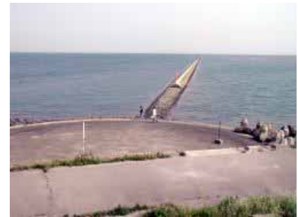
木曽川・揖斐川導流堤 《提供：木曽川文庫》
