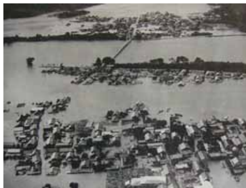
長良川での破堤状況（芥見地先）
