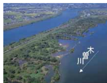
ケレップ水制群 木曽川 12～24km 付近
