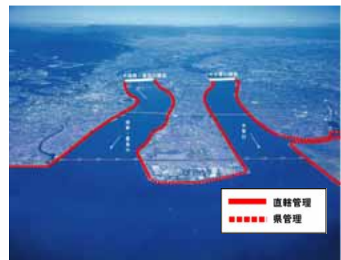
高潮堤防の整備区間
