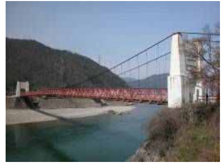
美濃橋 長良川 71.1k 付近 《提供：美濃市》
