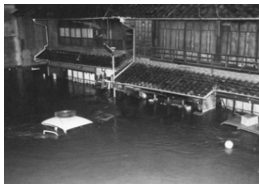
美濃加茂市街の浸水状況
