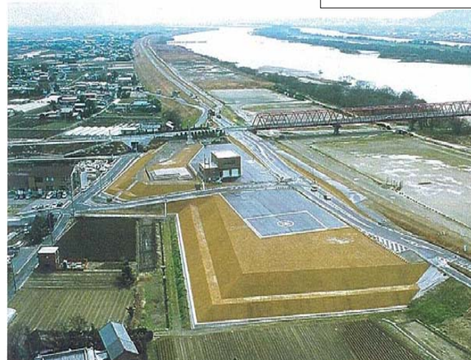
木曽川高畑地区河川防災ステーション
