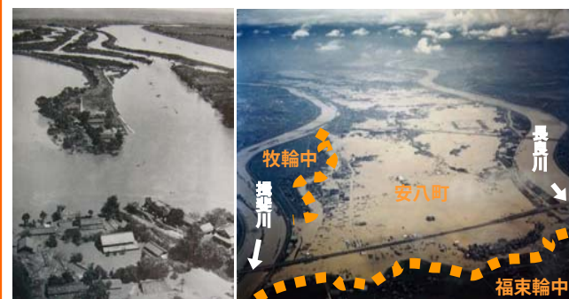
昭和34年8月洪水 （牧田川右岸浸水状況）
