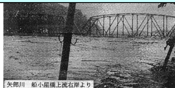
昭和28年6月洪水 船小屋橋
