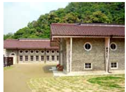
鏡岩水源地ポンプ室 長良川 53k 付近 《提供：岐阜市》
