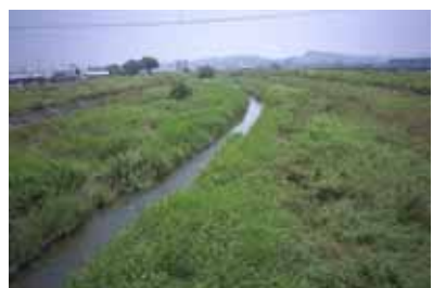
多度川 1k 付近
