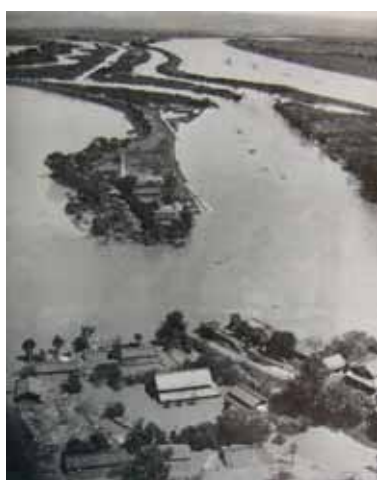
牧田川破堤状況（根古地地先） 出典：岐阜県災異誌
