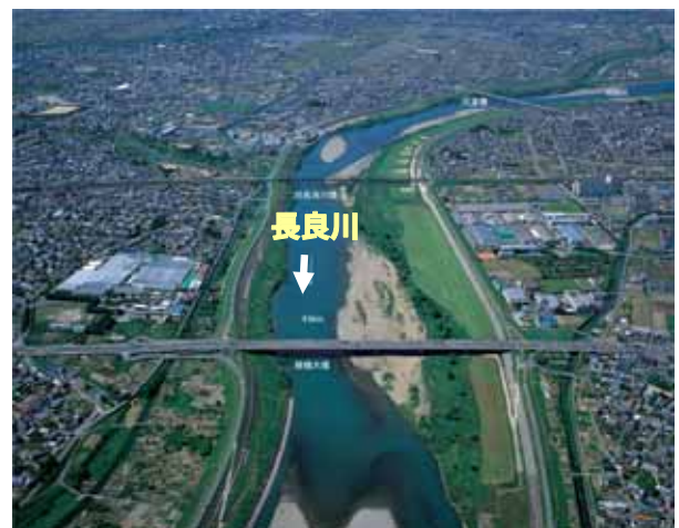
JR 長良川橋付近
