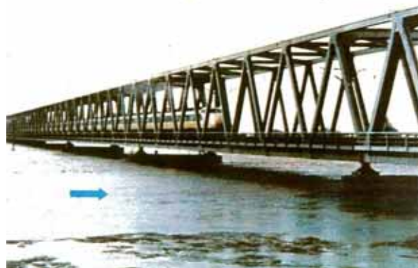
新幹線揖斐川橋の状況
