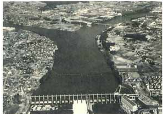
今渡ダム (昭和 14 年完成) (ピーク発電に伴う流況変動を安定させるための逆調節用ダム) 《提供：木曽川流域誌》
