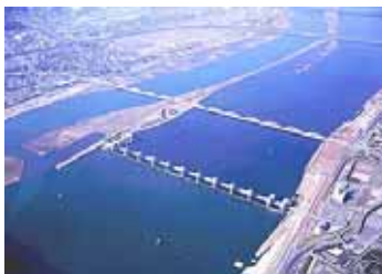
長良川河口堰 長良川5.5k付近
