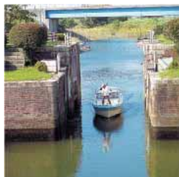
船頭平閘門 木曽川 12k 付近 《提供：愛西市》
