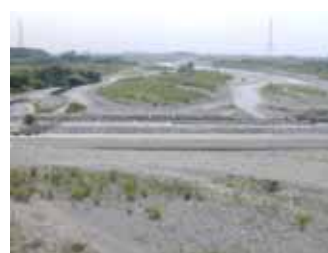
平野庄橋付近の瀬切れ 揖斐川49.6k付近
