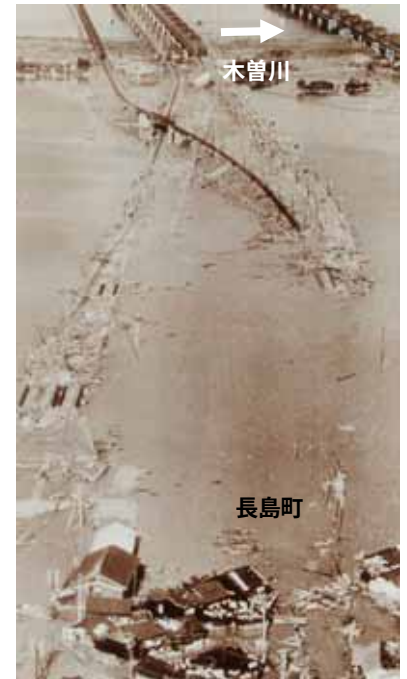
木曽川周辺の被災状況
