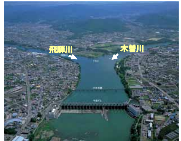
今渡ダム付近の状況
