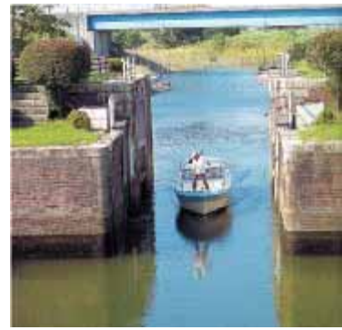
船頭平閘門 木曽川 12k 付近 《提供：愛西市》
