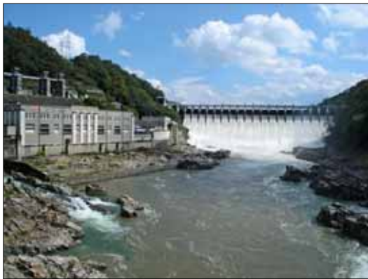
大井ダム (大正 13 年完成) (我が国初の本格的なダム式発電所) 《提供：木曽川流域誌》
