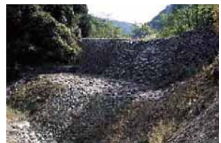
羽根谷一号堰堤 《提供：岐阜県》
