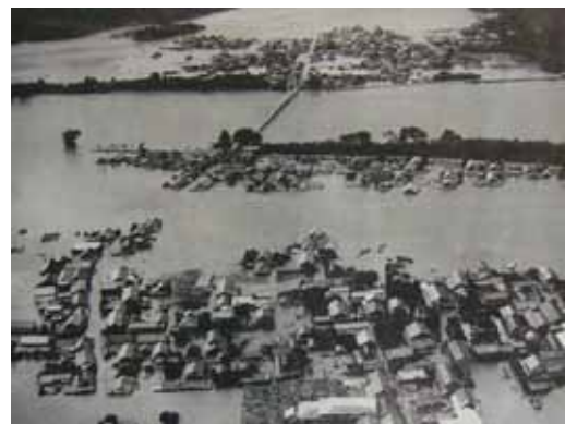
長良川での破堤状況（芥見地先）
