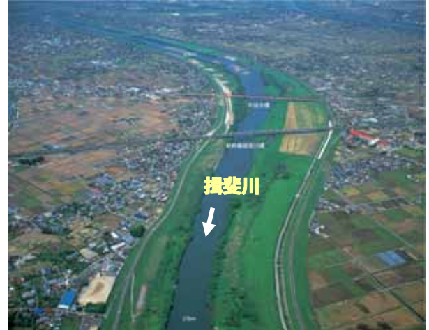
新幹線揖斐川橋付近
