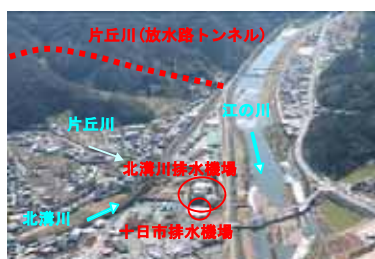
北溝川排水機場
