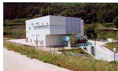
願万地排水機場
