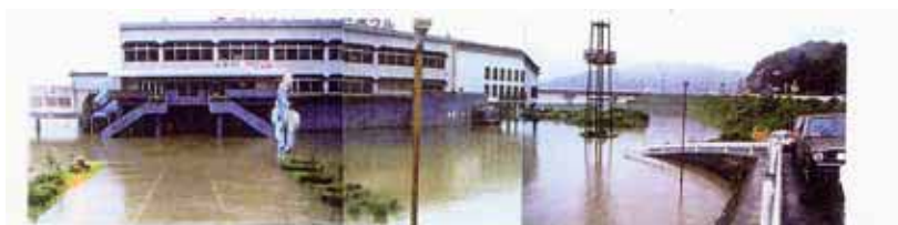
三次市寿橋付近の浸水状況
