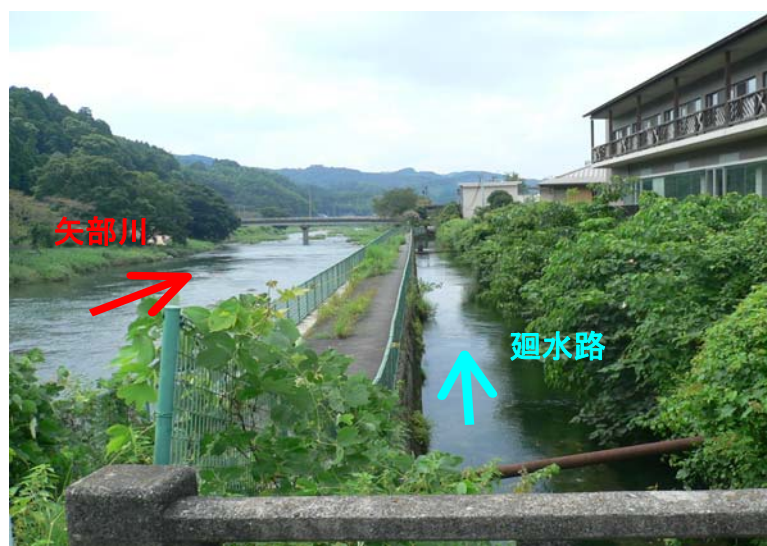
写真-5.1 廻水路の状況（黒木廻水路）
