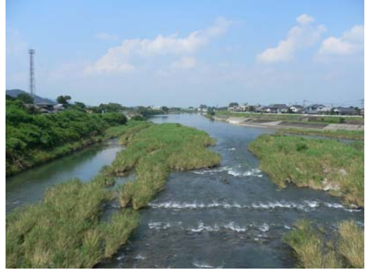
24/800 付近（氾濫原区間） 河床は礫が主となり、平瀬を形成している。 流れは速く
