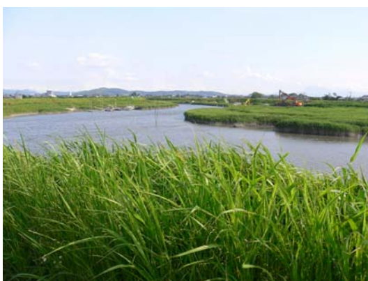
5/400 付近（飯江川合流点） 感潮区間でガタ土が堆積している。汽水域の干潟にはヨシ群落が繁茂している。
