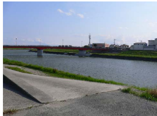
10/400 付近（湛水区間） 堰が連続し湛水している区間。流れも穏やかで安定している。
