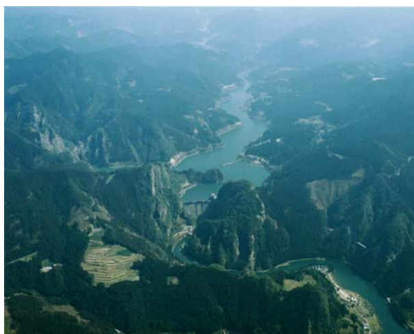
図-1.2(1) 矢部川上流部（日向神ダム）
