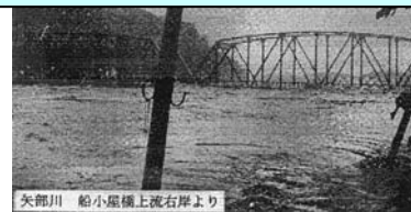
昭和28年6月洪水 船小屋橋
