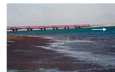
河口域の干潟 (揖斐川右岸1.8k付近)
