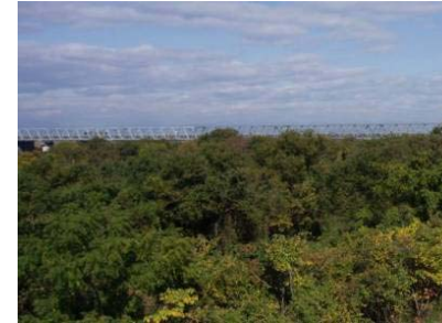
著しく繁茂した樹林 (木曽川31.0k付近左岸)
