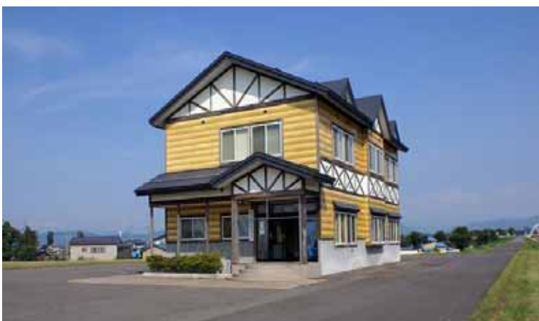
十文字河川防災ステーション
