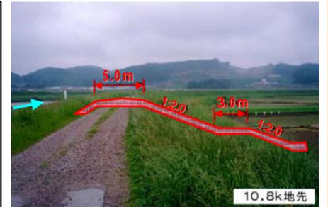
沿川の洪水被害の軽減を図るうえで、支川の改修と調整し、合流点処理を実施
