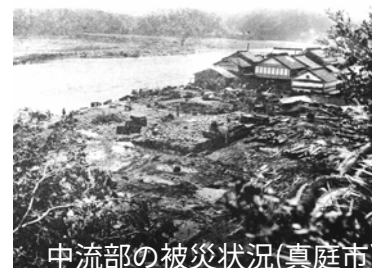
中流部の被災状況(真庭市)
