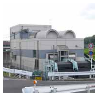
倉安川排水機場
