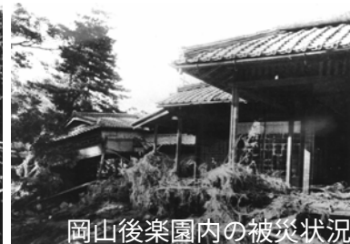
岡山後楽園内の被災状況
