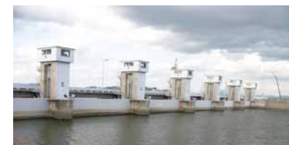
百間川河口水門の改築
