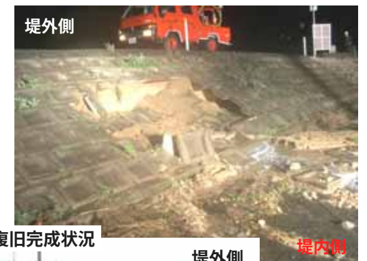
緊急復旧完成状況
