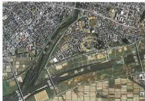
大曲捷水路完成後（平成 11 年）
