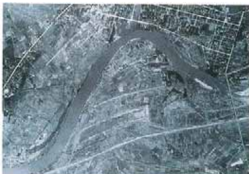
大曲捷水路改修工事着工前（昭和 36 年）
