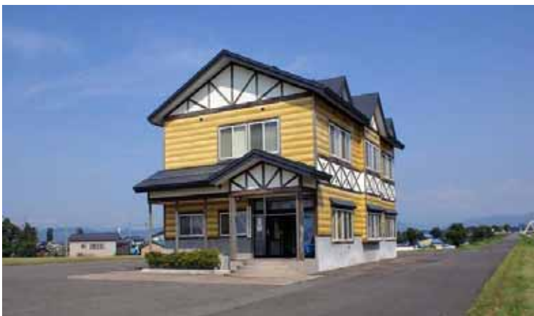
十文字河川防災ステーション
