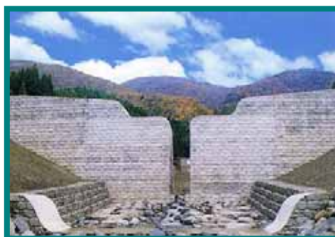
黒沢川第 1 砂防えん堤
