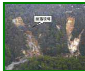
先達川被害状況(H9)
