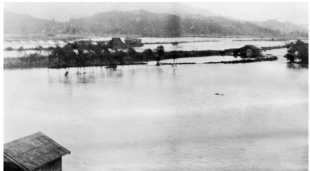
一面冠水した集落（旧福岡町荒屋敷）
