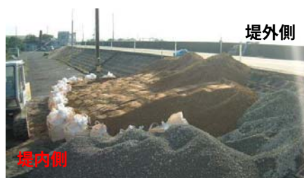
緊急復旧完成状況
