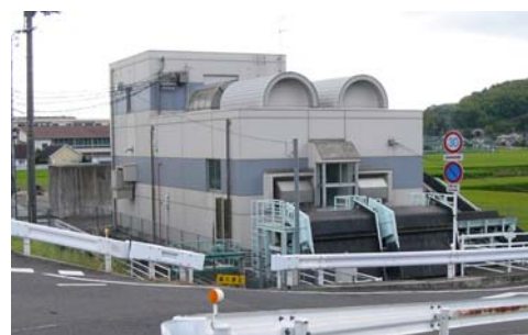
倉安川排水機場
