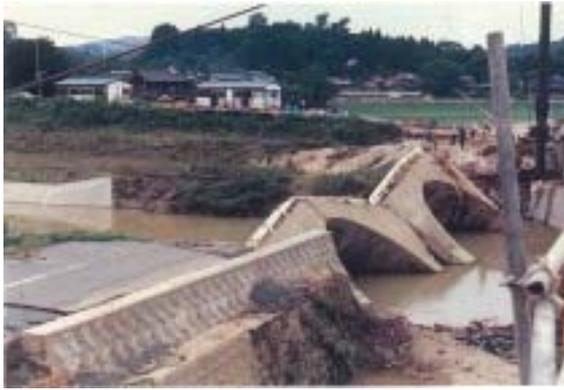
写真 4-5(2)支川和仁川 0.6km 付近(三加和町)平野橋の流失状況
