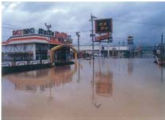
写真 4-6(5)国道 3 号の浸水状況(熊入地区)
