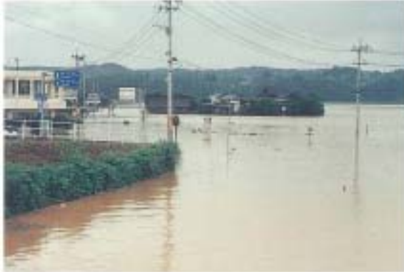
写真 4-6(3)国道 443 号の出水状況(山鹿市)
