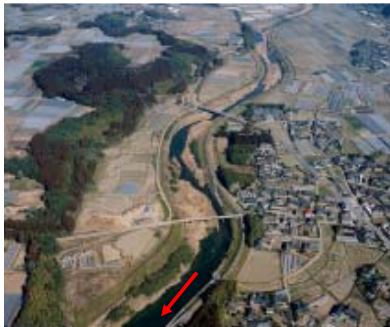
【1.74k 山鹿市ちぶさん橋付近の河道の状況（支川岩野川）】
