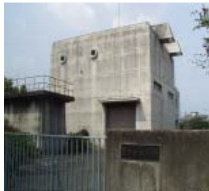
[玉名排水機場]
