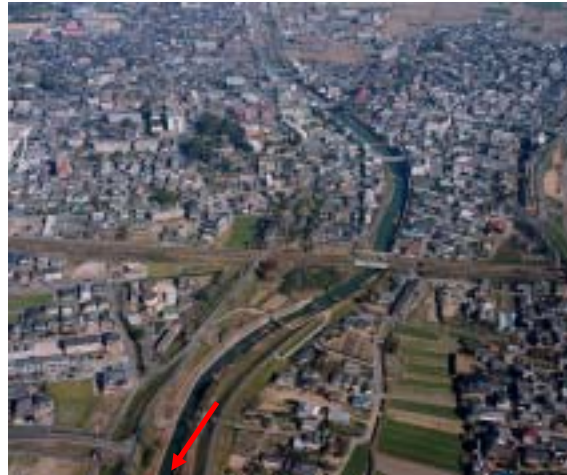
【7.375k 玉名市永徳寺の鉄道橋付近における河道の状況（支川繁根木川）】
