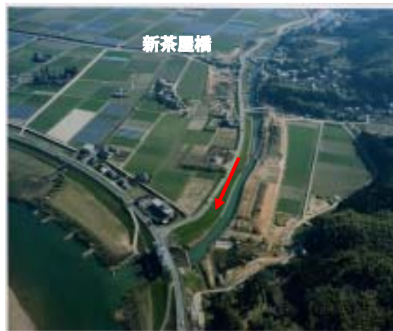
【1.06k 玉名市向迫間の寺田水門付近における河道の状況（支川木葉川）】
