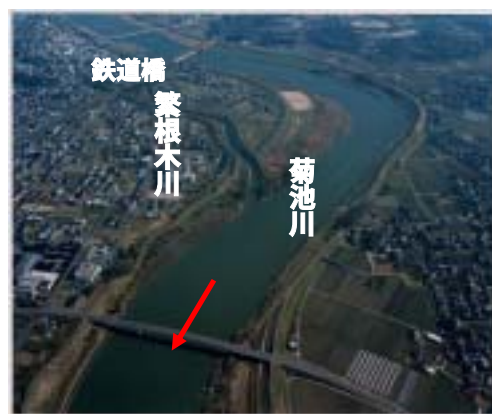
【7.4k 玉名市永徳寺の鉄道橋付近における河道の状況】
