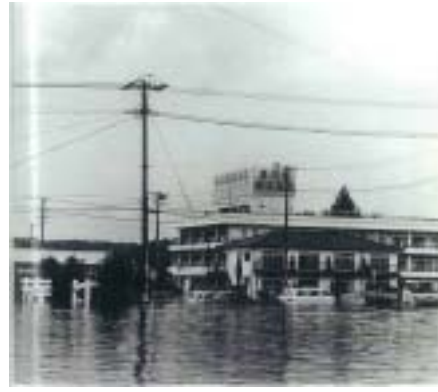
写真 4-5(3)山鹿市新町付近の浸水状況
