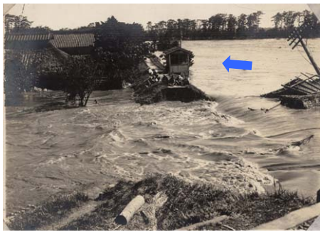
久慈川本川堤防決壊（左岸） （日立市留）
