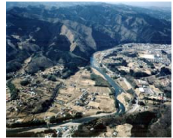
写真2-2 中流部の状況 (太子町 河口から 60km)
