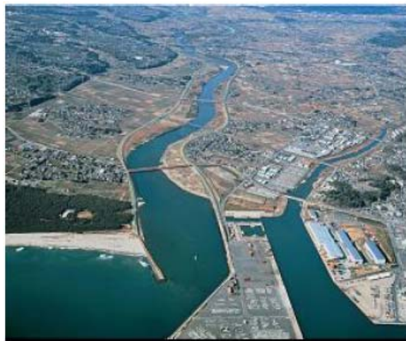
写真4-8 河口付近（2006年12月撮影）
