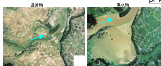
粟原床固付近の浸水状況(茨城県那珂市)
