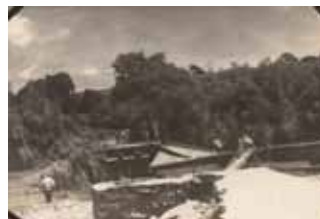
洪水によって破壊された支川里川の茅根橋(茨城県常陸太田市)
